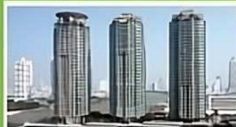
The Chatrium Hotel & Residence อาคาร 37 ชั้น 3 ตึก 2006
